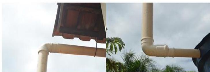
Figura 8. Conexão do joelho e bucha 1 de redução.
