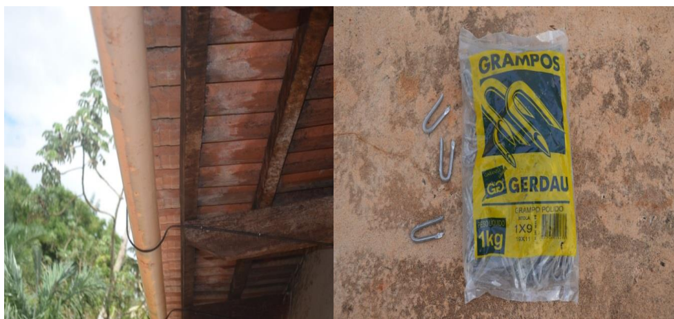
Figura 11. Foto da fixação dos suportes de calhas.
