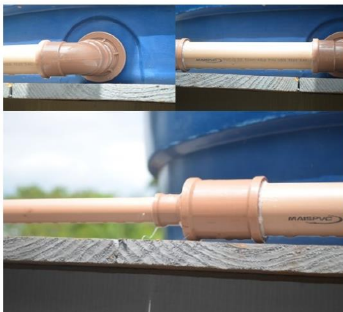
Figura 9. Flange, joelhos e bucha redutora.
