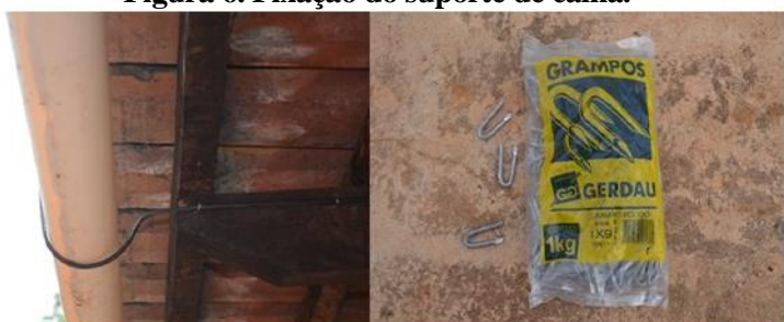
Figura 6. Fixação do suporte de calha.
