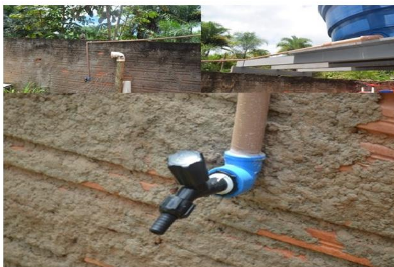
Figura 10. Barra de cano 25mm, joelhos e torneira.
