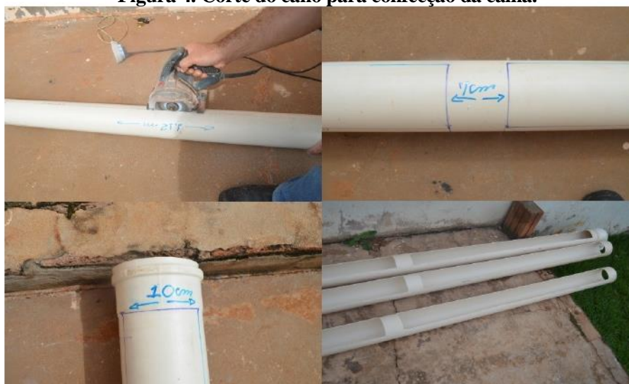
Figura 4. Corte do cano para confecção da calha.
