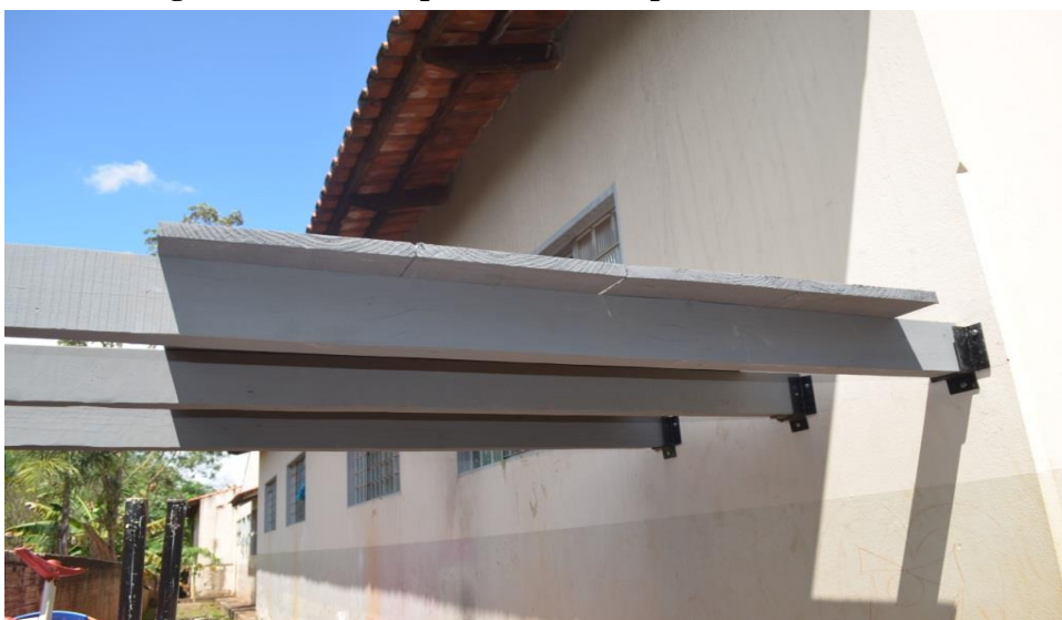
Figura 8. Foto do suporte metálico e parafusos instalados.
