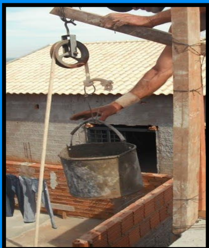
Figura 7 – Uso de roldana na construção
